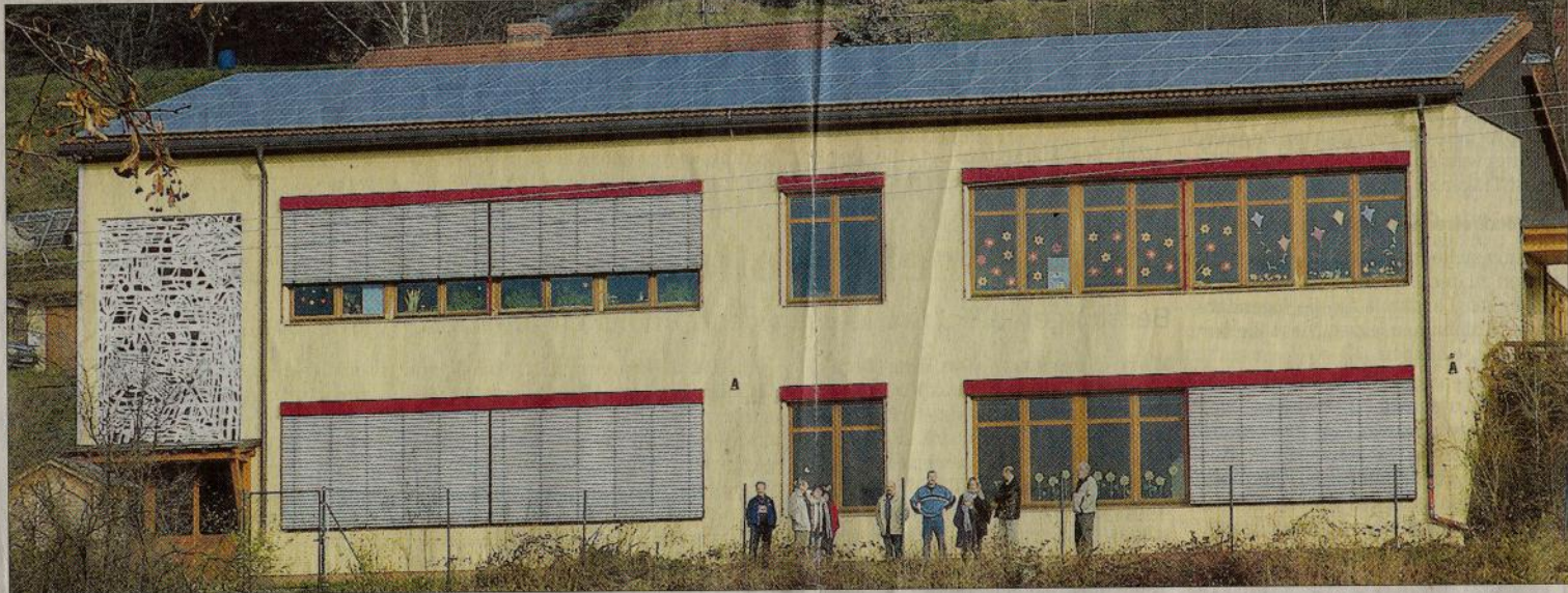
Auf 260 Quadratmetern des Neuhüttener Schuldaches wird die Energie der Sonne in Strom verwandelt. Michael Stenger aus Krommenthal hat das Dach für 20 Jahre gemietet. Am Samstag erläuterte er dem Gemeinderat die Anlage. Foto: Horst Born
